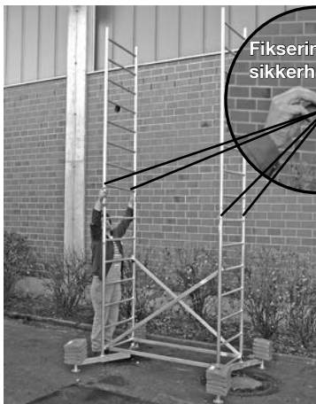
Grundmodul med første og anden tilbygning
