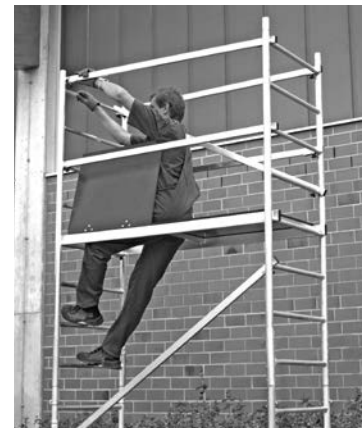
Základné lešenie s prvou nadstavbou
