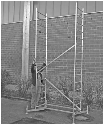
Grundgerüst mit erster Aufstockung
