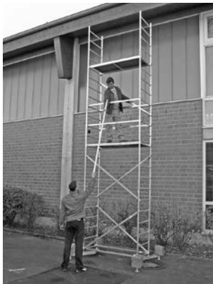
Grundgerüst mit erster und zweiter Aufstockung
