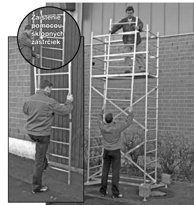
Základné lešenie s prvou a druhou nadstavbou
