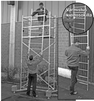
Perustelineet kahdella lisäkerroksella
