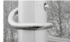
Alle forbindelser skal sikres med sikkerhedsclips.
