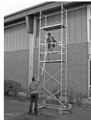
Grundmodul med første og anden tilbygning
