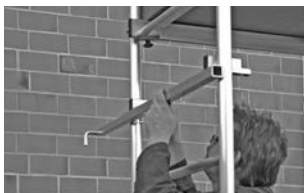
Échafaudage de base avec première rehausse
