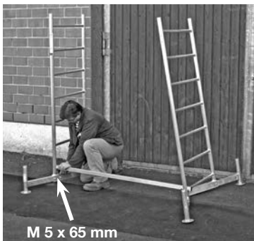
Základné lešenie s prvou nadstavbou
