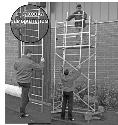
Базовая конструкция с первой и второй надстройками
