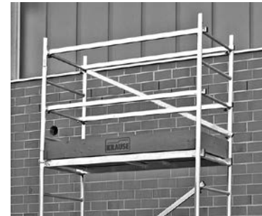
Perustelineet yhdellä lisäkerroksella
