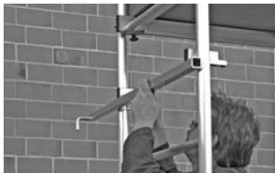
Basissteiger met eerste slag
