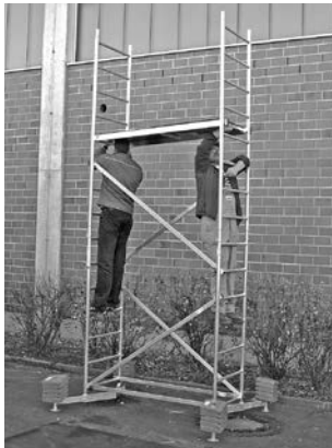
Grundgerüst mit erster und zweiter Aufstockung
