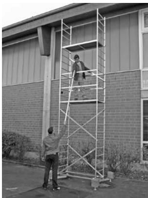
Échafaudage de base avec première et deuxième rehausses
