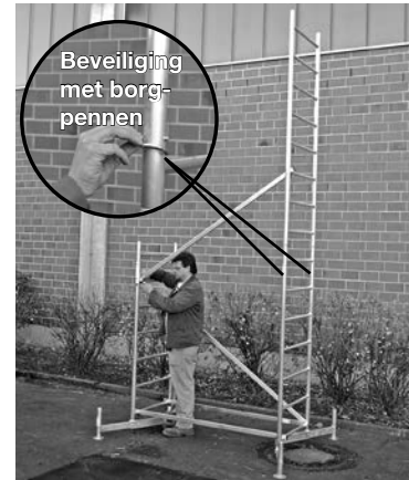
Basissteiger met eerste slag
