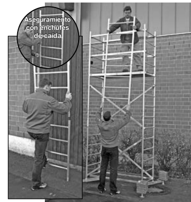
Andamio básico con primero y segundo piso
