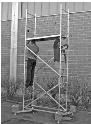
Echafaudage de base avec première et deuxième rehausses
