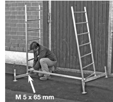
Perustelineet yhdellä lisäkerroksella
