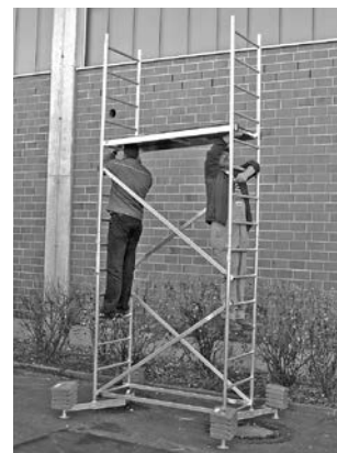
Grundmodul med første og anden tilbygning
