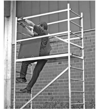
Basissteiger met eerste slag
