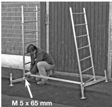
Podstawa rusztowania z pierwszą kondygnacją.
