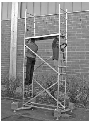
Basisplatform met eerste en tweede slag
