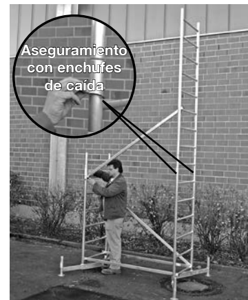
Andamio básico con primer piso
