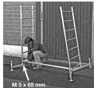
Grunnstillas med første tilbygg
