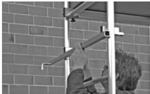
Grundgerüst mit erster Aufstockung
