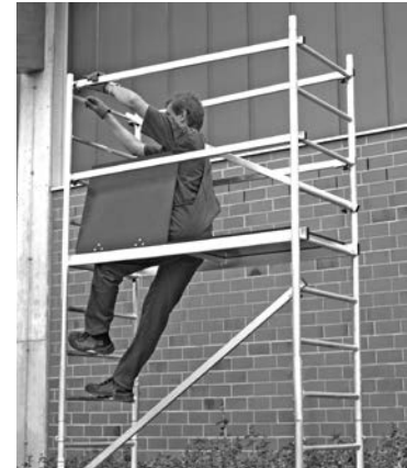
Andamio básico con primer piso
