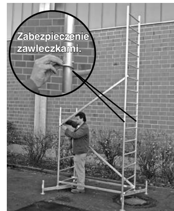
Podstawa rusztowania z pierwszą kondygnacją.
