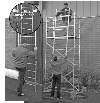
Grundgerüst mit erster und zweiter Aufstockung
