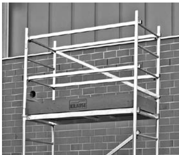
Grundgerüst mit erster Aufstockung
