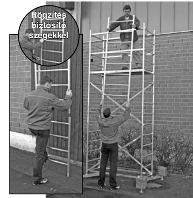
Alapállvány első és második magasítással
